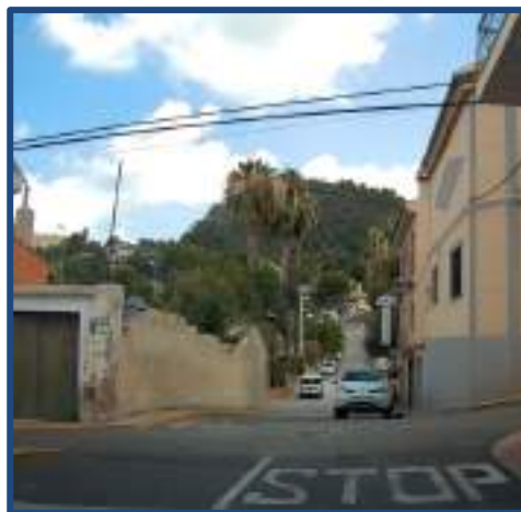
Ilustración 47 Señalización horizontal inexistente
